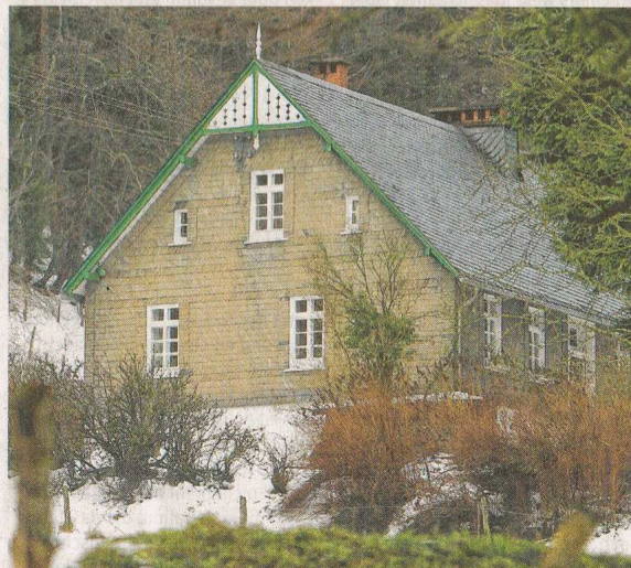
Forsthaus-Tradition am Waldesrand: Das Dach ist im alten Stil neu gedeckt und der Giebel entspricht jetzt wieder dem Originalzustand. FOTO: MARK KEPPLER
